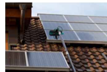
Das Reinstwasser wird am oberen Ende der Teleskopstange ausgeleitet und durch den Bürstenkörper gleichmäßig auf die Borsten und auf die darunterliegenden Solarzellen verteilt.
